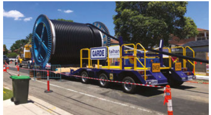
Posa e tiraggio del cavo nei condotti a Maiden Street, Greenacre
