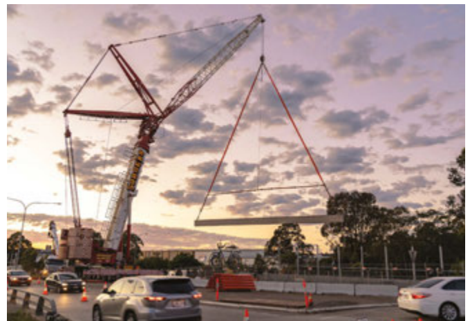
Εργασίες γέφυρας καλωδίων Muir Road κατά τη διάρκεια του τριημέρου του Οκτωβρίου
