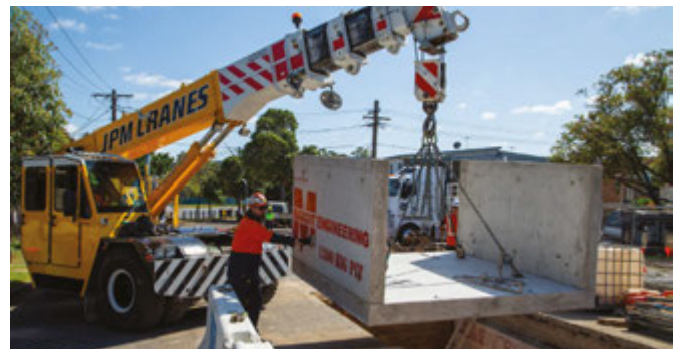
Κατασκευή φρεατίου ζεύξης καλωδίων στην Hillcrest Avenue, Greenacre
