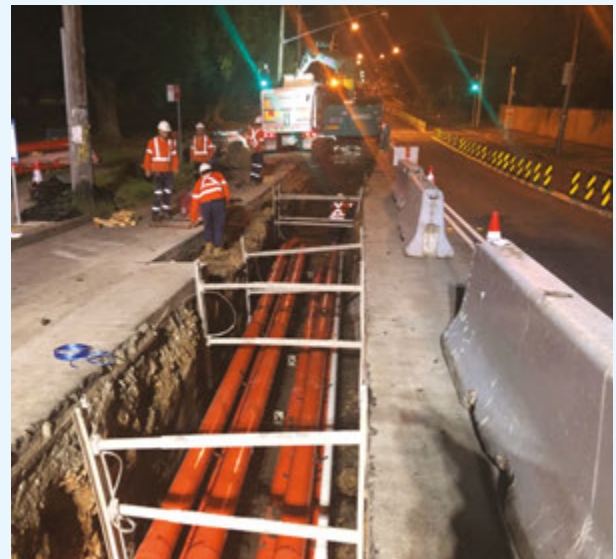
Costruzione di trincee lungo la Old Canterbury Road, Ashfield
