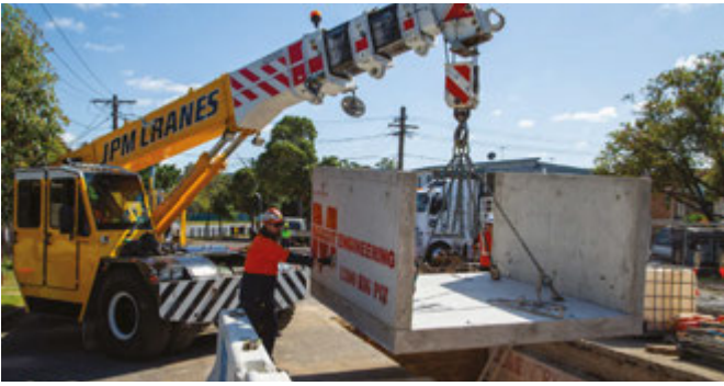
بناء أحواض التوصيلات المشتركة في Hillcrest Avenue, Greenacre
