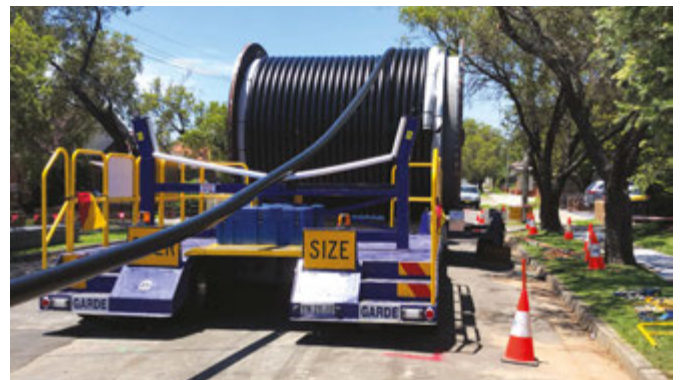
Chiếc xe tải lớn sẽ đậu trên các đường phố khi kéo cáp ra từ cuộn cáp và đưa vào các ống dẫn trong rãnh
