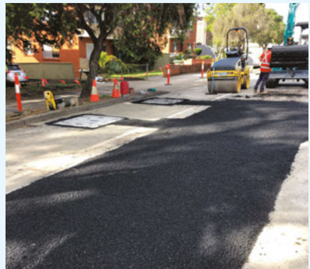
Προσωρινή αποκατάσταση οδού, Yangoora Road, Lakemba
